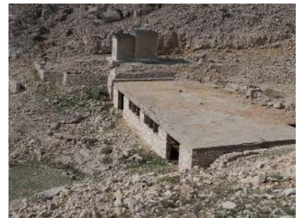
Fundamente eines früheren Gebäudes.
