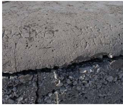
In Beton geritzte Inschrift.
