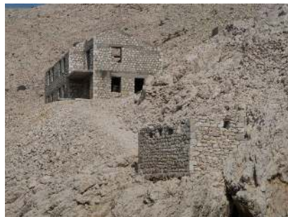
Ruine eines zweigeschossigen Gebäudes.
