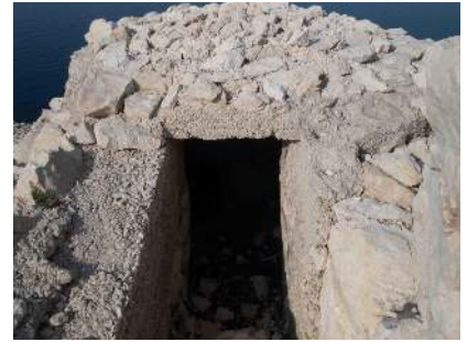
Eingang zu einem Steinunterstand.
