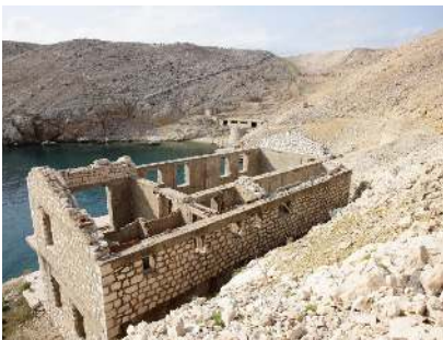
Dachloses Gebäude über einer Bucht.
