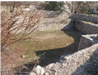
Blick über die Grube.
