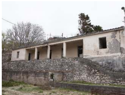
Gebäude mit Vorbau auf einer Stützmauer aus Stein.
