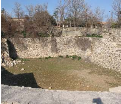
The edge of the pit.
