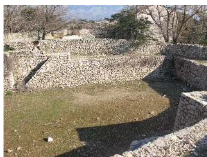
Mur de pierre sèche au fond de la fosse.
