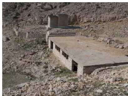
Fondations d'un ancien bâtiment.
