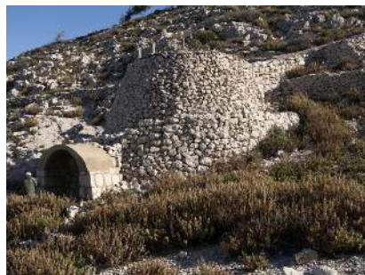
Construction en pierre à coupole.
