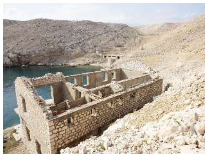
Murs au-dessus d'une crique.
