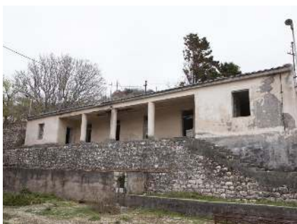
Bâtiment avec porche sur un soubassement de pierre.
