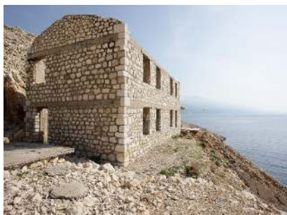
Bâtiment de pierre sans toit.
