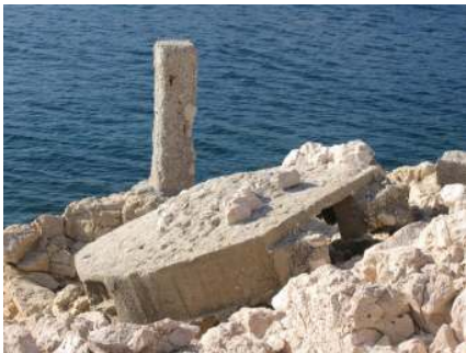
Srušeni stup na obali.
