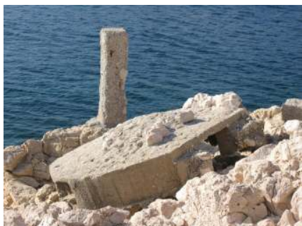
Pilastro crollato sulla riva.
