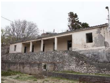
Edificio con portico su un muro di sostegno in pietra.
