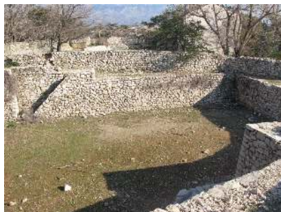
Muro a secco presso il fondo della fossa.
