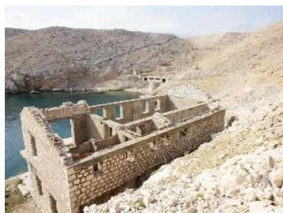
Muri sopra la baia.
